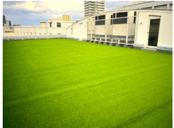
旧中学校棟屋上
